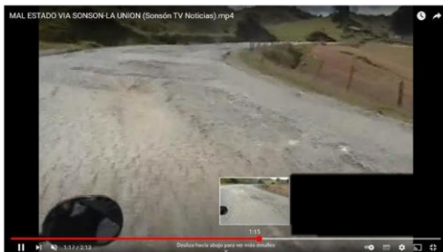
PAVIMENTO FLEXIBLE 22 km vía Mesopotamia – Sonsón (Antioquia) Pavimentada 2002 + 2 repavimentaciones
