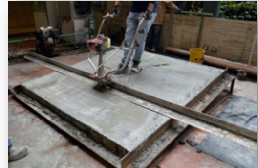
Fig. Instalación de UHPFRC con pendiente del 10%
