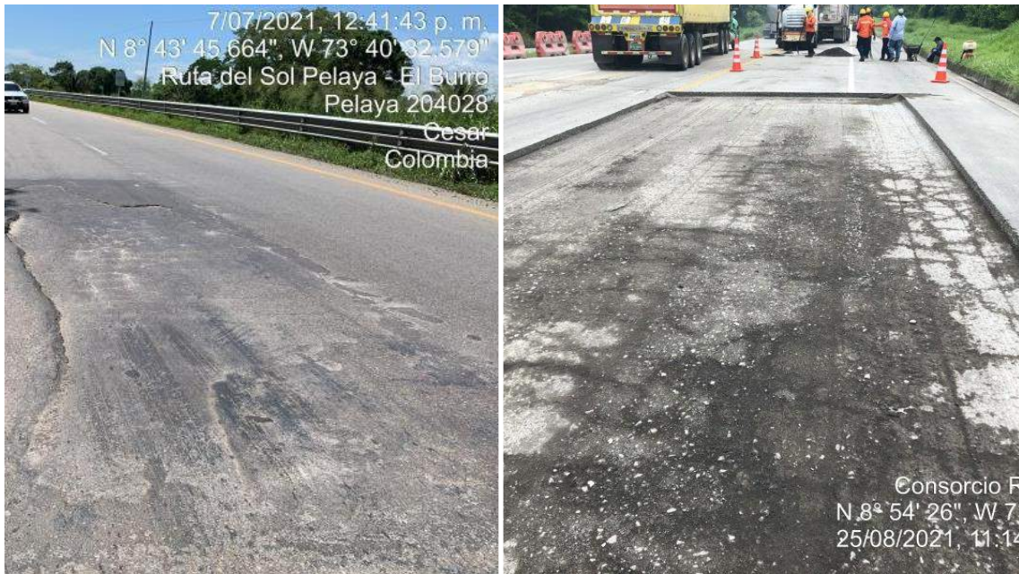
Figura 6.4: Fresado de capa superficial de pavimento para proceso de repavimentación
