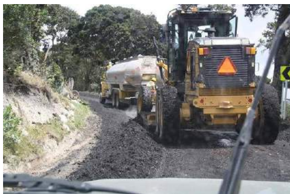
Figura 8.5: Fresado estabilizado en UsmeFuente: Recuperado de alcaldía local de Sumapaz
