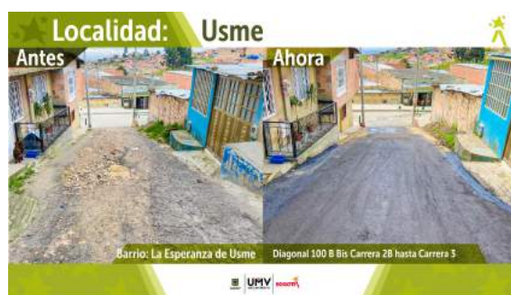
Figura 8.4: Fresado estabilizado en UsmeFuente: Recuperado redes sociales URMV
