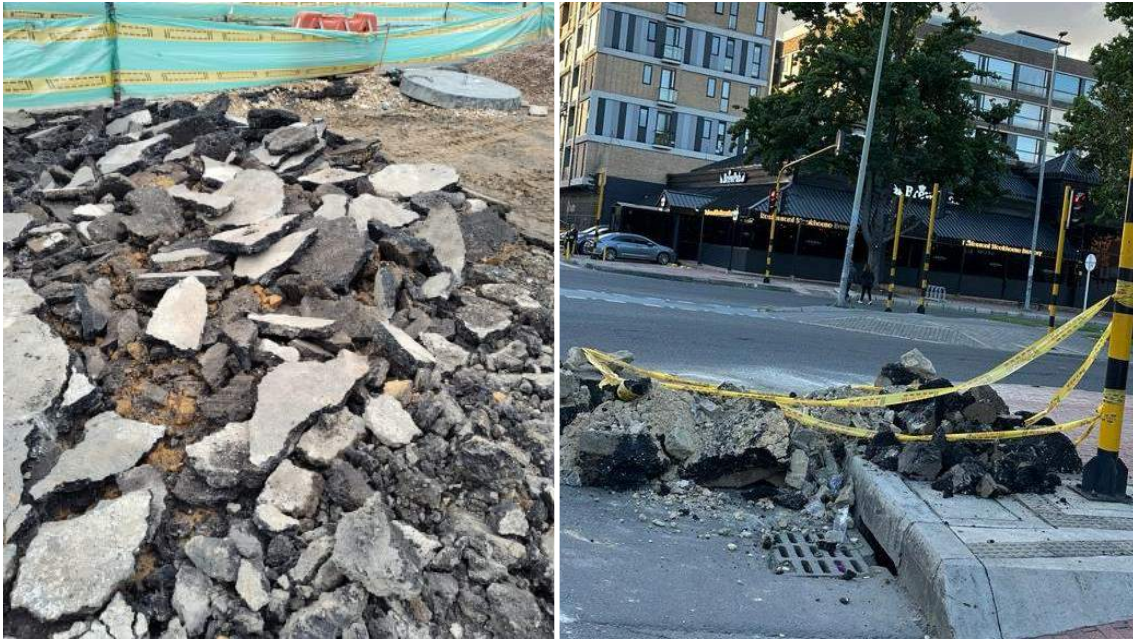
Figura 6.2: Demolición de pavimentos
