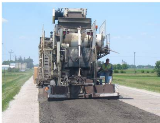
Figura 8.10: Mezclas asfáltica fría con RAP
