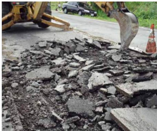
Figura 4.8: Bloques producto de demolición
