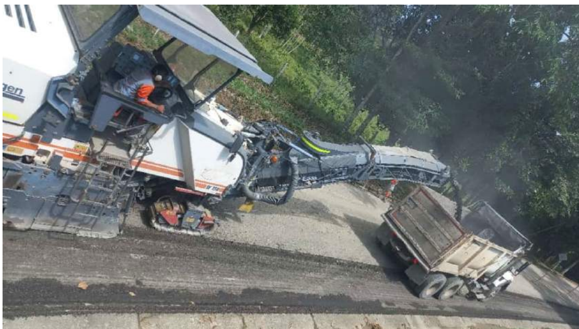
Figura 6.3: Fresado del pavimento
