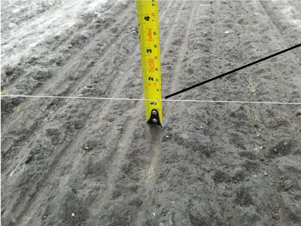
**Espesor del fresado
